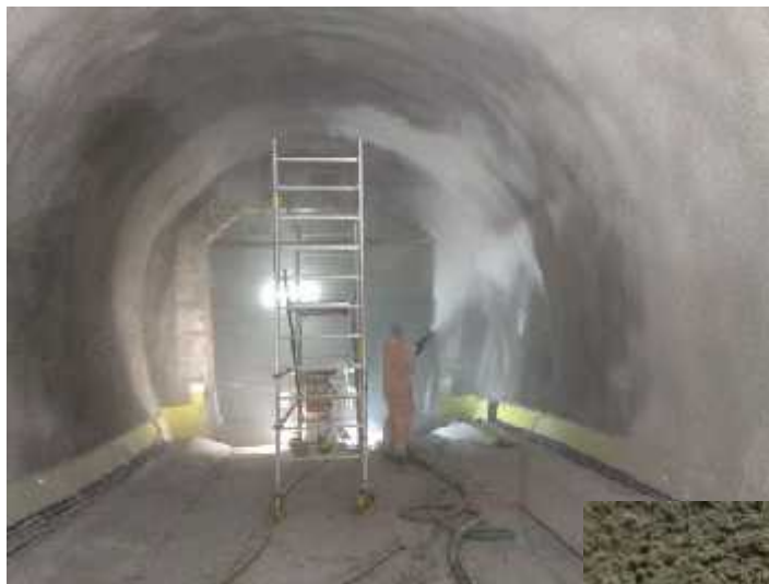
Nanášení penetrační vrstvy stříkané izolace
