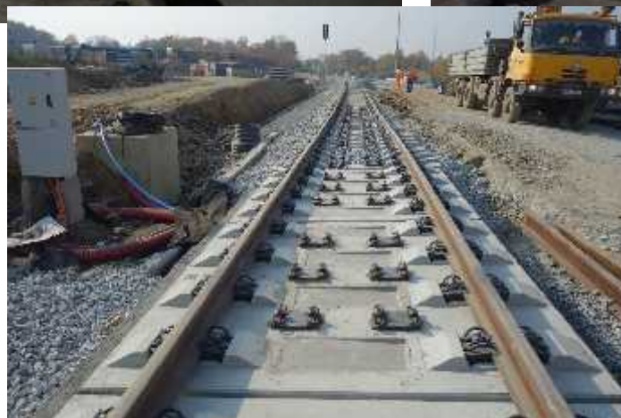
Realizace pechodové oblasti u tunelu Ejpovice
