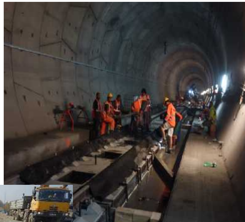
Vyplování samozhutnitelným betonem
