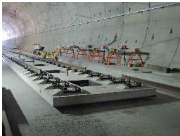
Instalace PJD v tunelu Ejpovice – uložení desek
