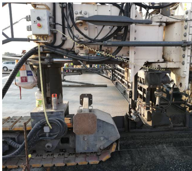
Obr. 1 Foto z průběhu pokládky zkušebního úseku vozovky s CB krytem s uplatněním strusky
