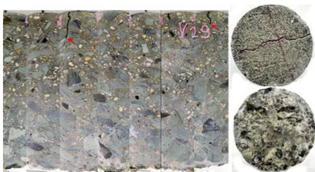
Obr. 2 Rozvinutá plocha povrchu vrtného jádra; trhlina šířky 1 mm se šíří pouze z povrchu do hl. max. 45 mm, Crack index pro svisle orientované trhliny v horní části vývrtu = 3,2 mm/m [5]
