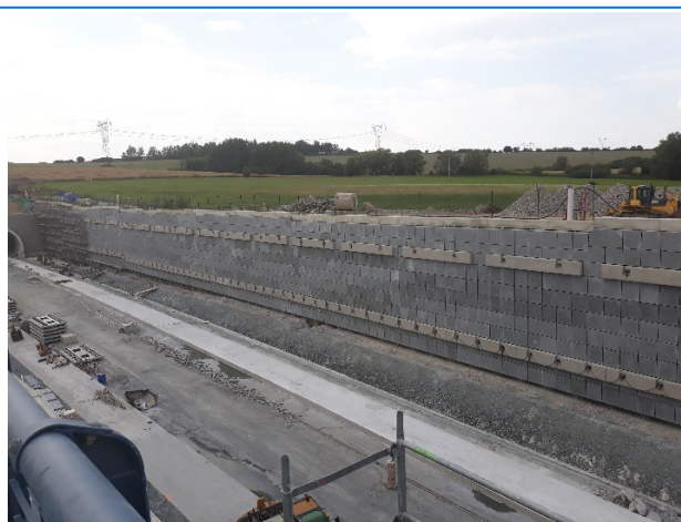
Obr.4 Skutečné provádění stěny
